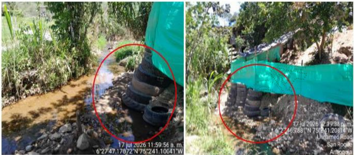
Figura 2. Imágenes fotográficas, tomadas en día de la visita de campo.
