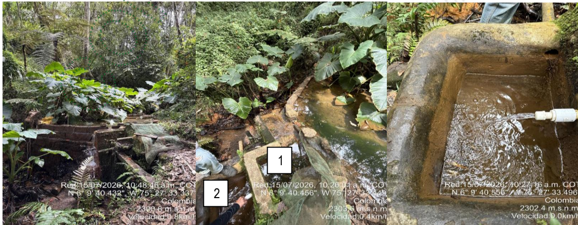
Represamiento y obra de captación en la fuente
