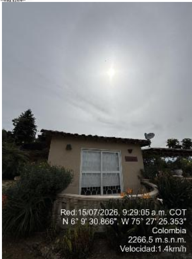
Vivienda San Lucas
