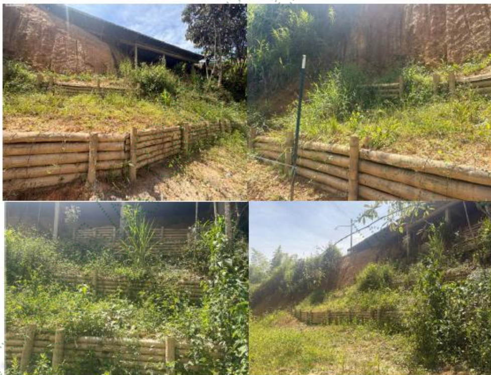
Imagen 1. Bioingeniería – Trinchos medida de mitigación.
