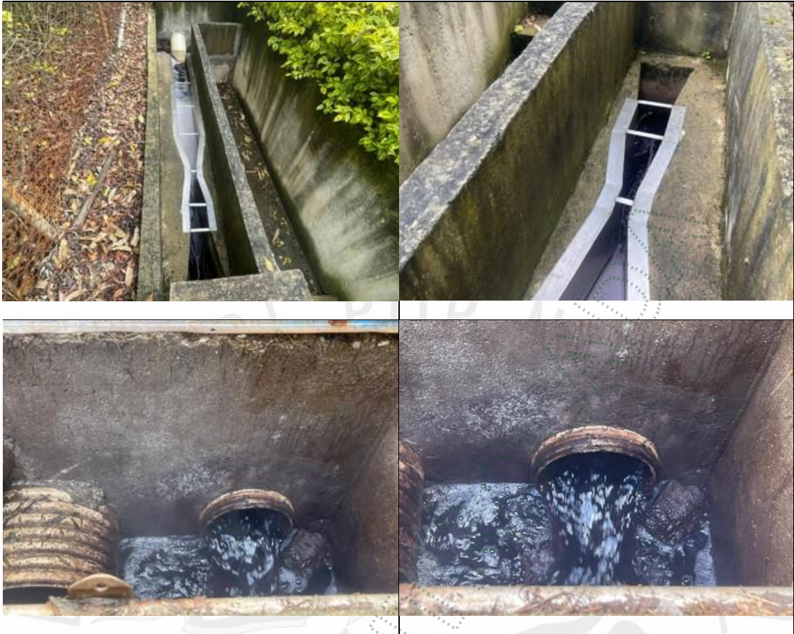
Estructura de salida
