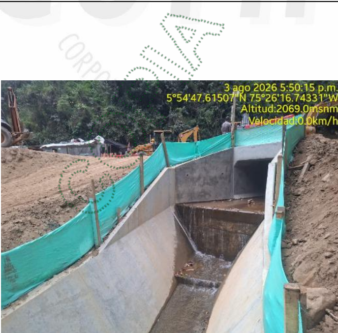
Ilustración N°. 4 Box Culvert construido (descole)
