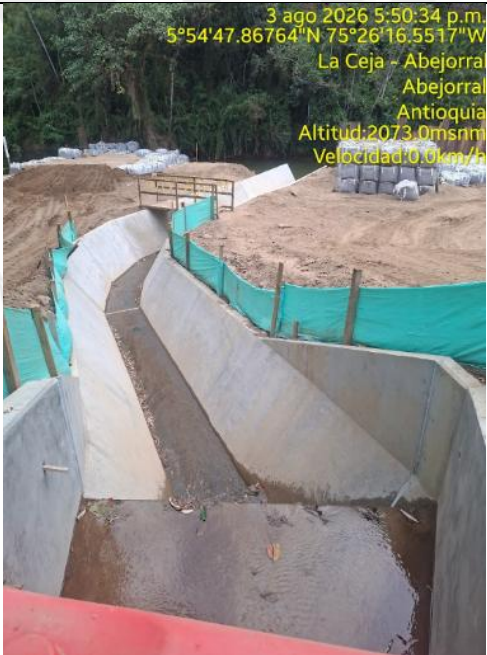
Ilustración N°. 5. Canal Trapezoidal Escalonado
