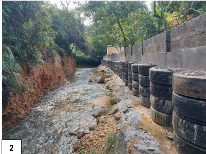
Evidencias fotográficas del muro de contención, sobre la quebrada El Silencio Fuente: Cornare 2026
