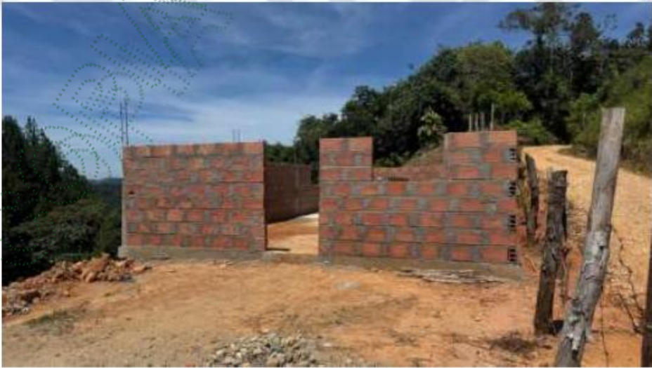
Imagen 2. Vivienda en construcción
