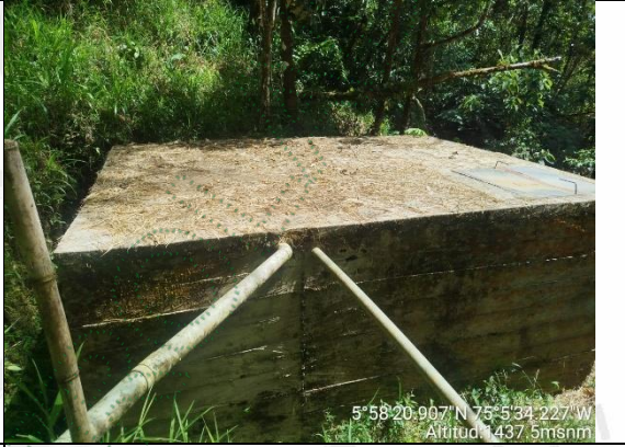
Figura 4. Tanque de almacenamiento.
