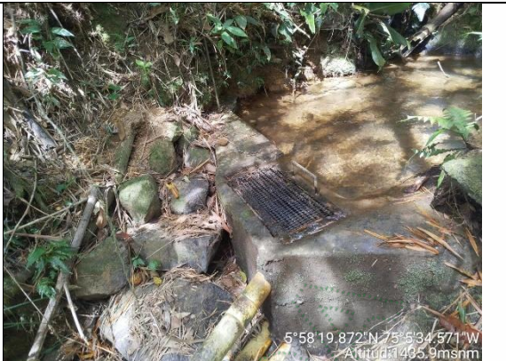
Figura 2. Bocatoma del acueducto.
