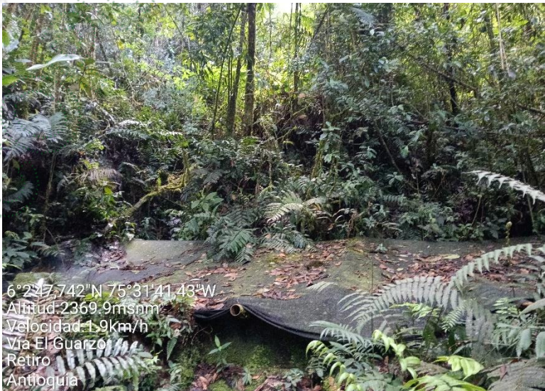
Imagen 4. Punto de captación.
