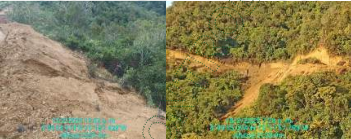
Rastros de material que ya está bajando al Río Áures con las aguas lluvias.
