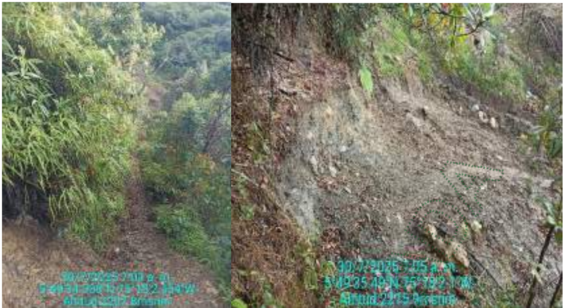
Punto de suspensión de obras Punto donde conecta la vía con el tramo intevenido
