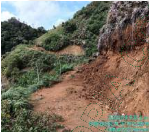
Desprendimientos de la banca – Talud interior
