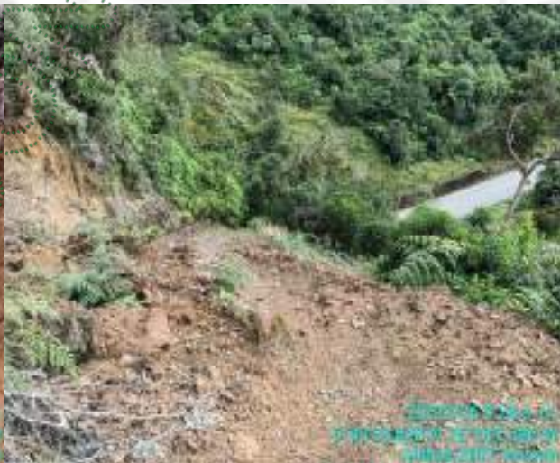
Desprendimientos de la banca – Talud interior
