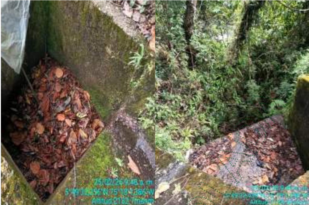
Obra que recibe las aguas lluvias abajo del lote arado y salida hacia el Río Áures
