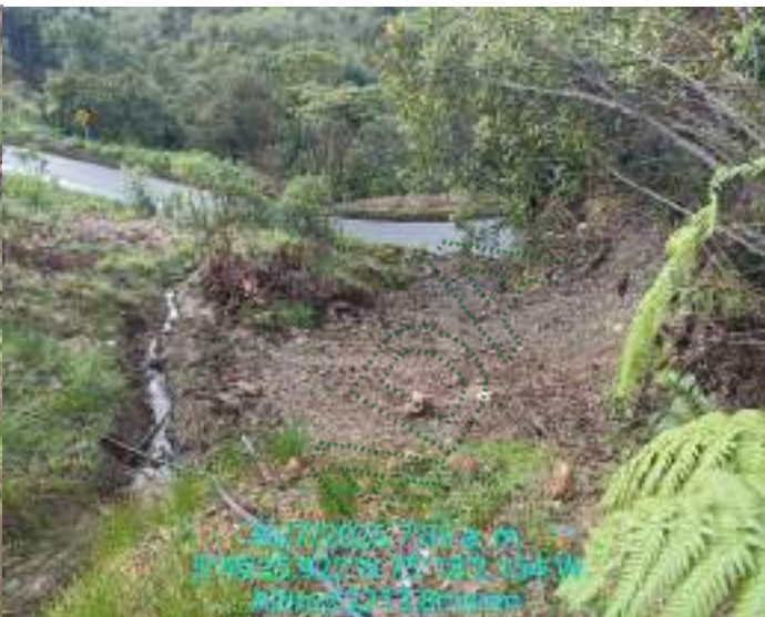
Vista desde adentro del predio hacia la vía a La Unión
