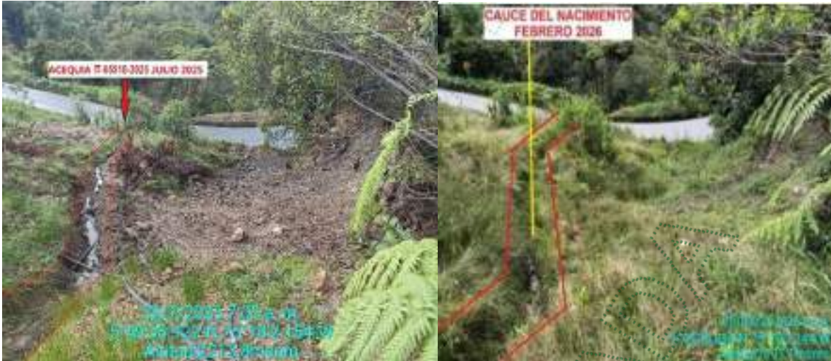
Izq. Foto tomada del IT-05510-205. Der. Cauce la fuente febrero de 2026
