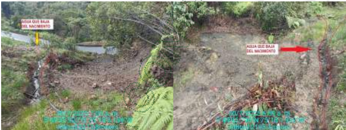
Acequia que conduce el agua del nacimiento a la berma de la vía.
