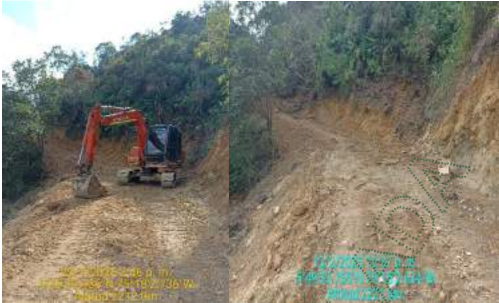
Maquinaria retirada del sitio
