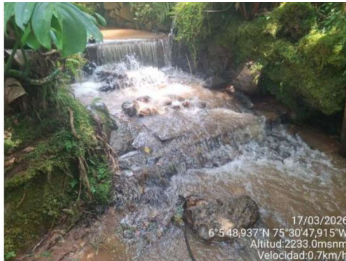
Imagen 3. Obra de captación
