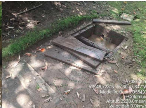
Imagen 4. Tanque desarenador.
