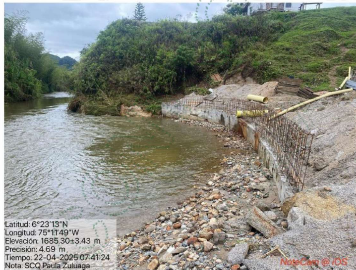
Imagen 4. Jarillón en construcción sobre la ribera del Río Concepción.
