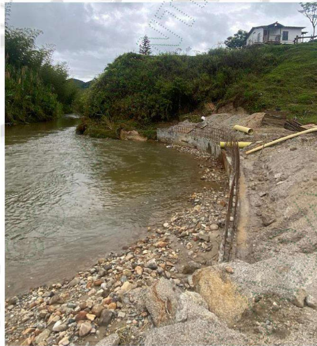
Imagen 3. Vivienda y jarillón en construcción.
