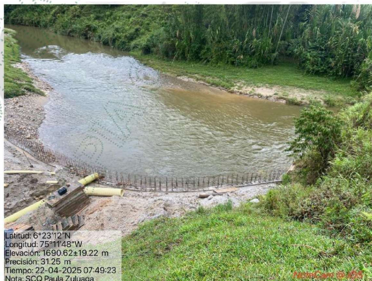
Imagen 4. Jarillón en construcción sobre la ribera del Río Concepción.
