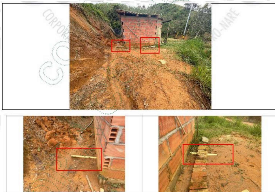
Imagen 1. Tuberías de la vivienda descarga de aguas residuales domésticas-grises y negras.
