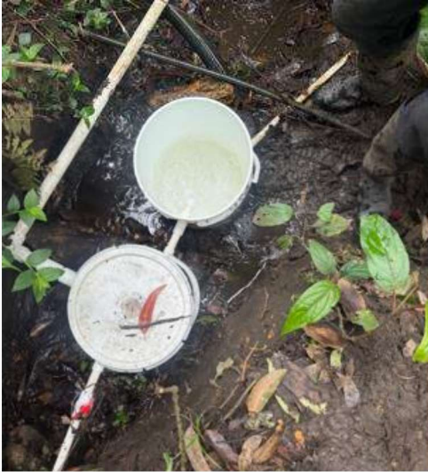
Obra de Capitación Económica
