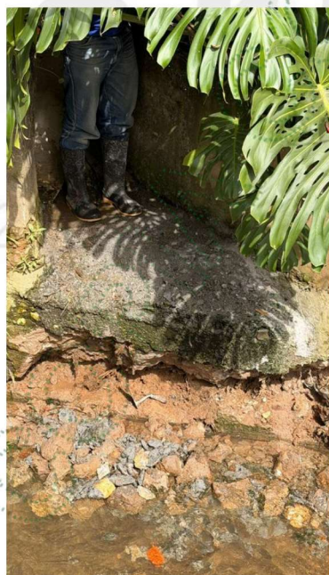
Ilustración 1 Registro antes de la adecuación.
