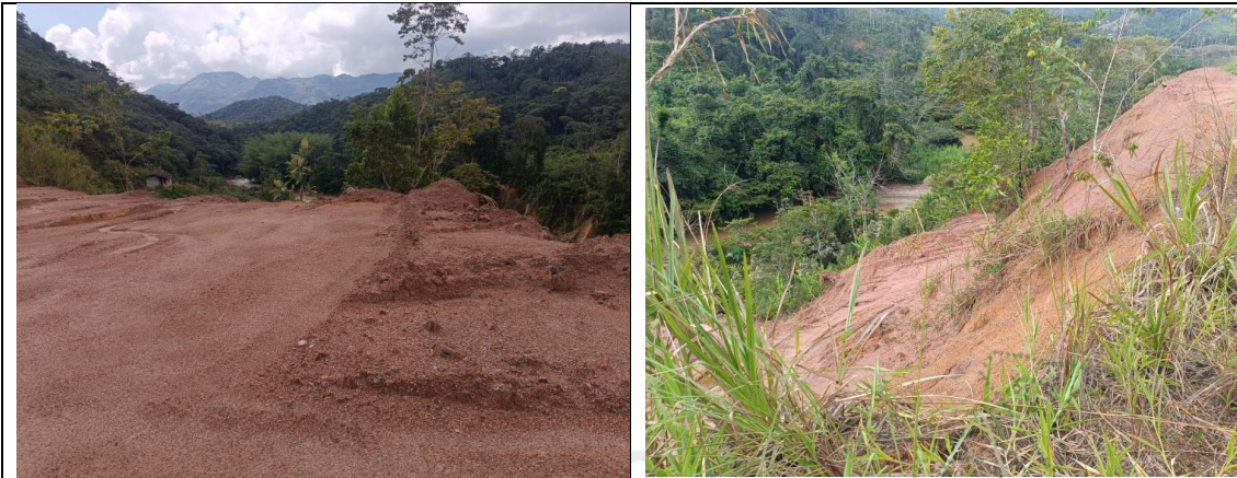
Imágenes 2,3,4 y 5 Estado actual del área intervenida
