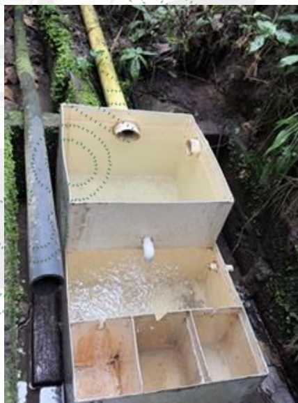
Imagen 3. Obra de captación fuente el cerro 1
