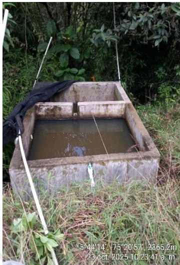
Imagen 7. Tanques desarenadores
