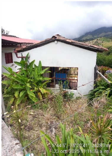
Imagen 2. Planta de tratamiento
