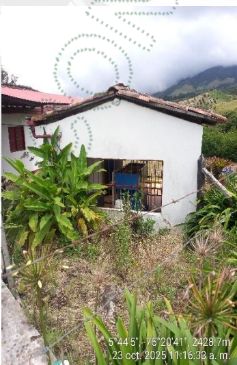
Imagen 10. Planta de potabilización
