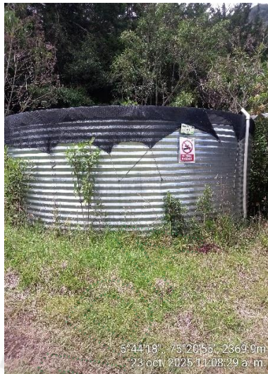
Imagen 7. Tanques desarenadores
