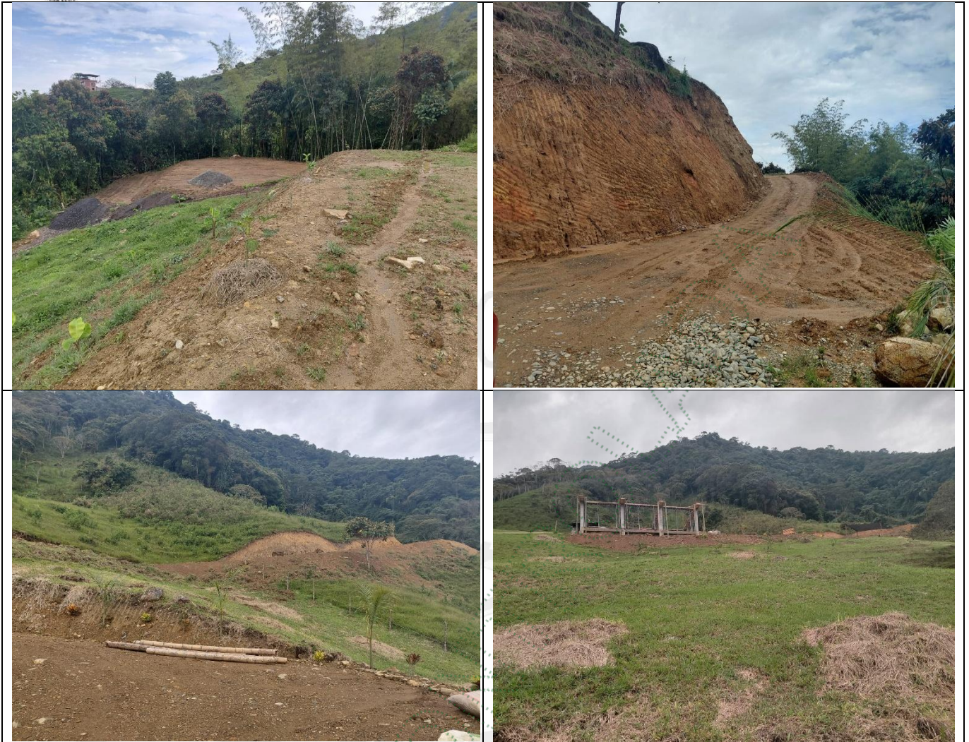
Explanaciones, vías internas e inicio constructivo de la primera vivienda.
