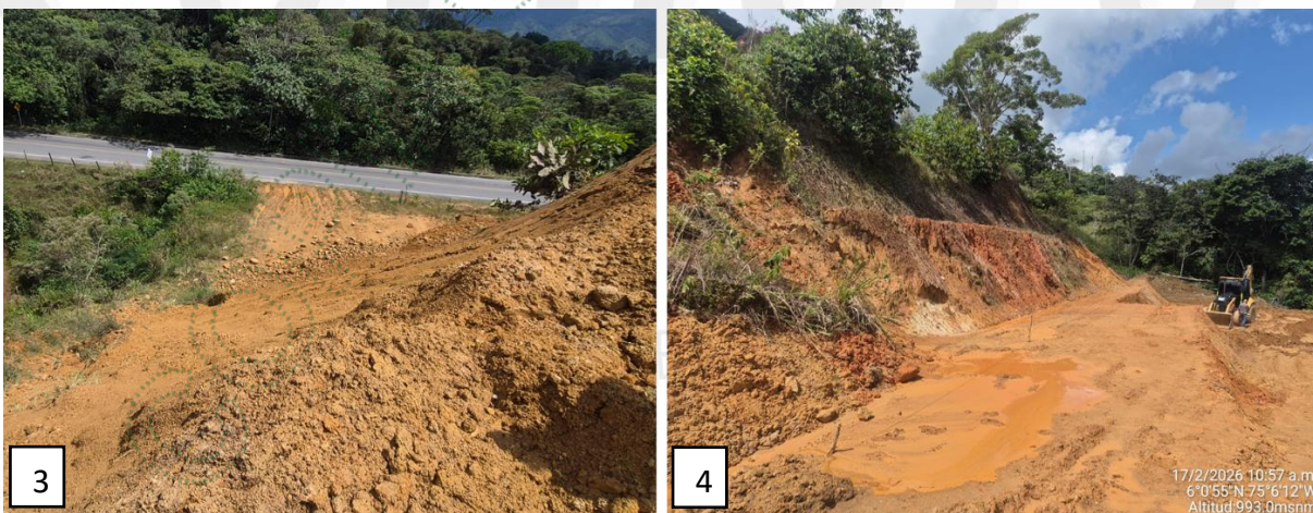
Imagen 3. Talud de relleno, Imagen 4. Talud de corte Fuente: Cornare, 2026
