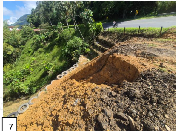
Imagen 6. Trinchos elaborados con llantas y acumulación de llantas en la pared del talud.
