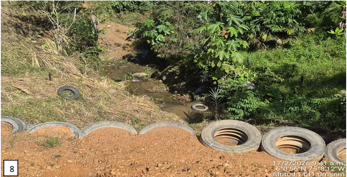
Imagen 8. Fuente hídrica ubicada en las coordenadas geográficas -75^{\circ}08'12.34'' W, 06^{\circ}00'56.65'' N, con procesos de sedimentación y con signos de contaminación asociados a los residuos provenientes del trincho en construcción con llantas.
