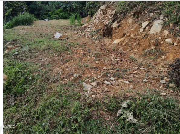
Imagen 2. Condiciones encontradas en el Banqueo N°2 . Fuente: Cornare 2026
