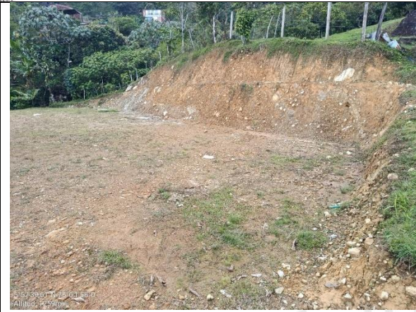
Imagen 1. Condiciones encontradas en el Banqueo N°1 . Fuente: Cornare 2026
