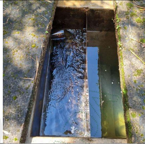
Imagen 3 y 4. Desarenador del recurso hídrico proveniente de la fuente denominada “Buenos Aires”. Fuente: Cornare 2026 – Visita de control y seguimiento expediente 056600232979.
