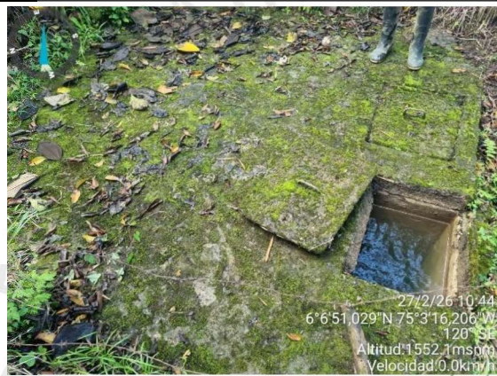
Imagen 5 y 6. Tanque de almacenamiento del sistema de captación de la vereda Buenos Aires Fuente: Cornare 2026 – Visita de control y seguimiento expediente 056600232979.
