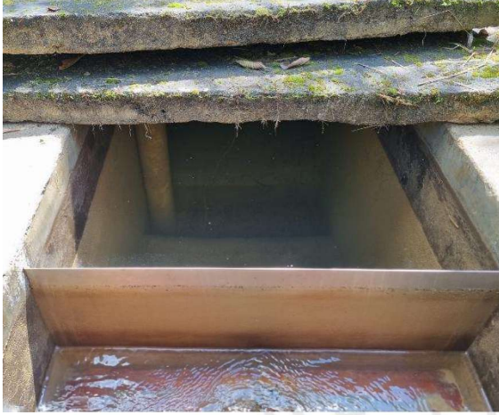
Imagen 3 y 4. Desarenador del recurso hídrico proveniente de la fuente denominada “Buenos Aires”. Fuente: Cornare 2026 – Visita de control y seguimiento expediente 056600232979.
