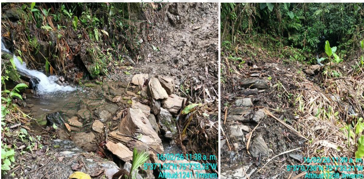
Derecha nuevo cruce del camino en la fuente – Izquierda intervención del margen de retiro piedras
