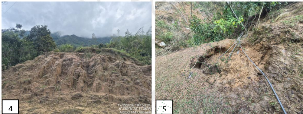
Imagen 4. Presencia de surcos y cárcavas en la ladera del talud.
