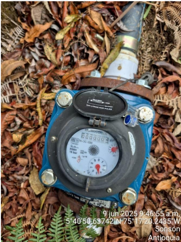
Imagen 2. Macromedidor instalado
