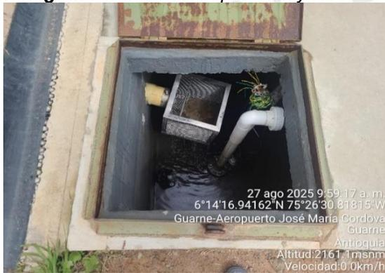
**Fotografía 5. Tanque de homogenización**
