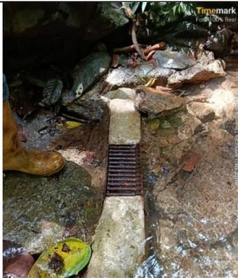
**Imagen 7.** Obra de captación tipo Pequeño Azud o presa de baja altura con rejilla - Empresa Calina fuente Quebrada Caño Grillero
