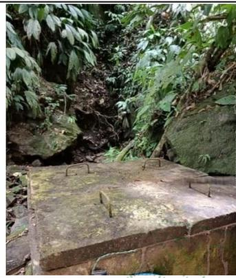
**Imagen 8.** Tanque desarenador y obra de control de caudal - Empresa Calina fuente Quebrada Caño Grillero
