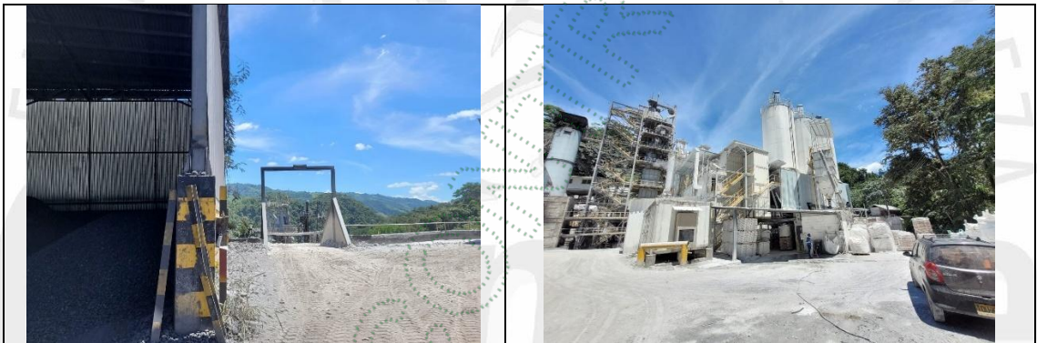
Imagen 17 y 18. Área de trituración, molienda y calcinación de la piedra caliza
