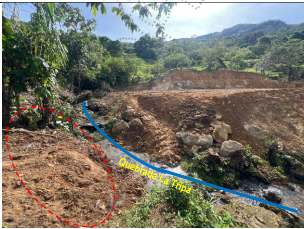
Foto 5 y 6. Material proveniente de la actividad de movimiento de tierras sedimentando fuente 1 Fuente: Cornare 2025.
