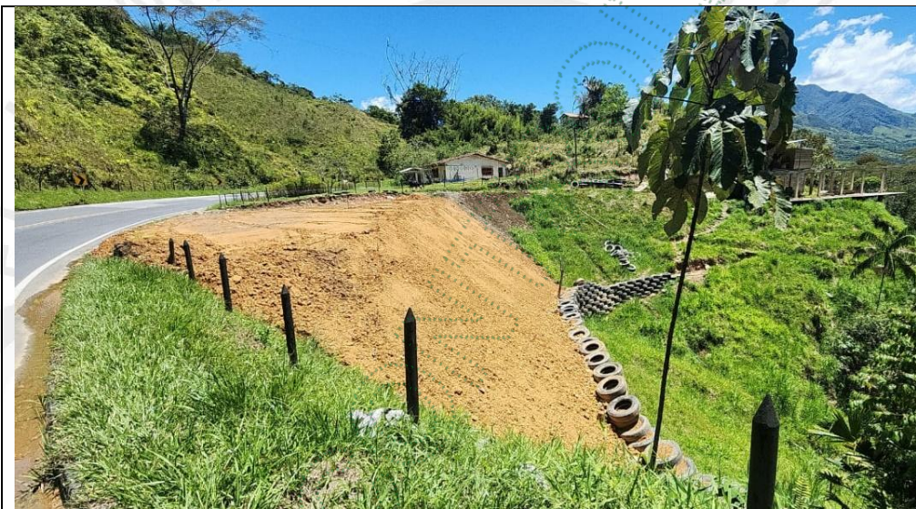
Imagen1. Adecuación del terreno con la construcción de un trincho con llantas. Cornare 2025
