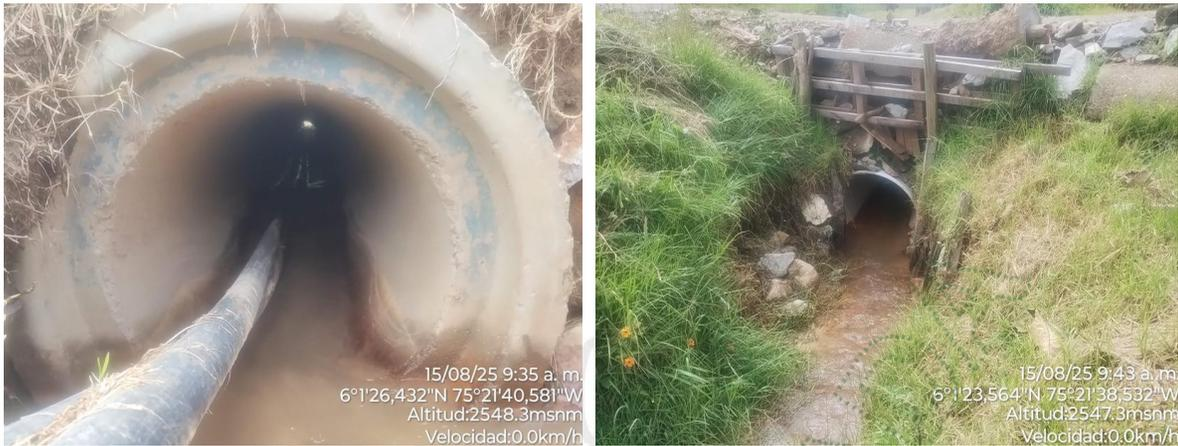
En el sitio se puede observar que actualmente se encuentran implementadas unas tuberías, la primera obedece a un cruce vial nuevo, y requerido por la Corporación el trámite de ocupación de cauce, y en la segunda fotografía se observa una tubería existente. En los dos puntos se debe realizar intervención para dar cumplimiento a los diseños presentados en el trámite ambiental de ocupación de cauce.
