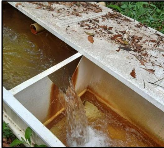
Imagen 1: Obra de control de caudal implementada para la fuente “Los Benitos”
