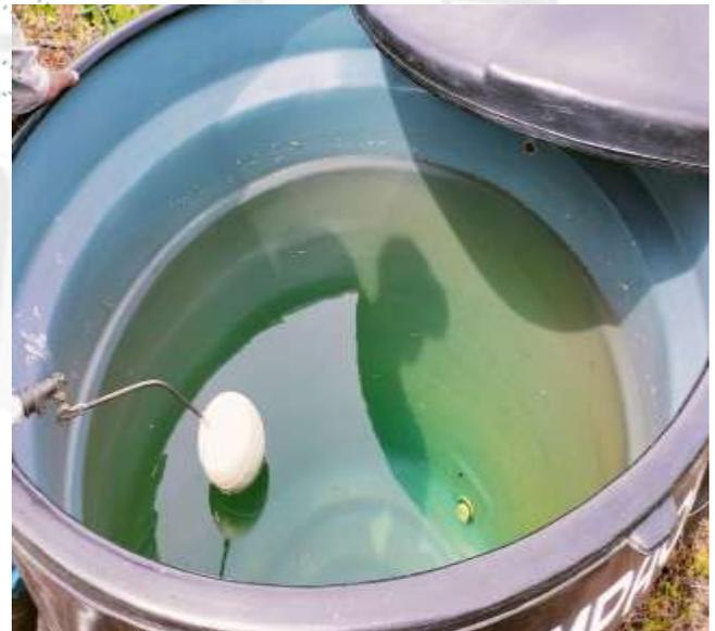
**Imagen 8 y 9.** Sistema de almacenamiento de agua con dispositivo de control de flujo.
