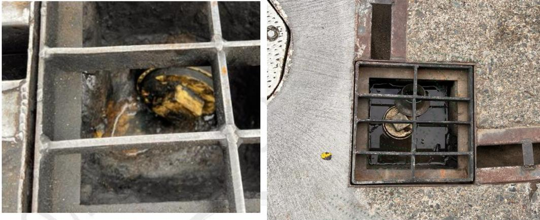
Foto 4 y 5. Tapón ubicado en la entrada de la tubería que conduce al sistema de trampa grasa para el manejo de las ARnD. Fuente: Cornare 2025
