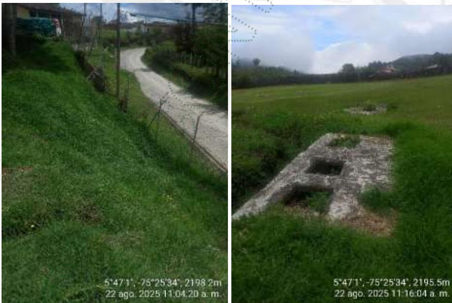
Imagen 2. Izq. Punto de vertimiento edificación 2 y posible ubicación del pozo séptico prefabricado. Der. Ubicación del pozo séptico en mampostería lleno de tierra.
