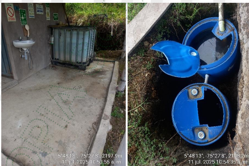
Imagen 5. Zona de preparación y duchas. STARnD con tanque de almacenamiento.
