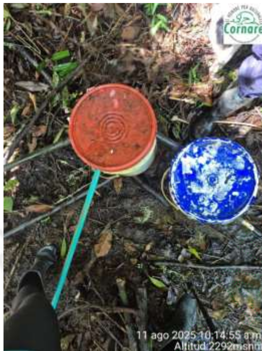
Imagen 2. Obra de captación y control de caudal.
