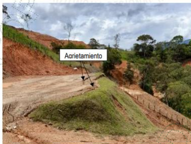
Foto 6. Agrietamiento en zona de formación de movimiento en masa o cárcava. Fuente: Cornare, 2022.
