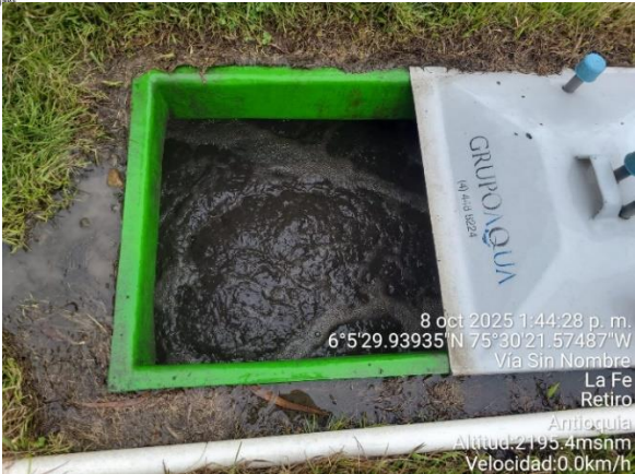
Fotografía 3. Planta OXI-AQUA. Cámara aireación
