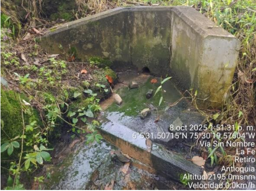
Fotografía 10. Estructura de descarga
