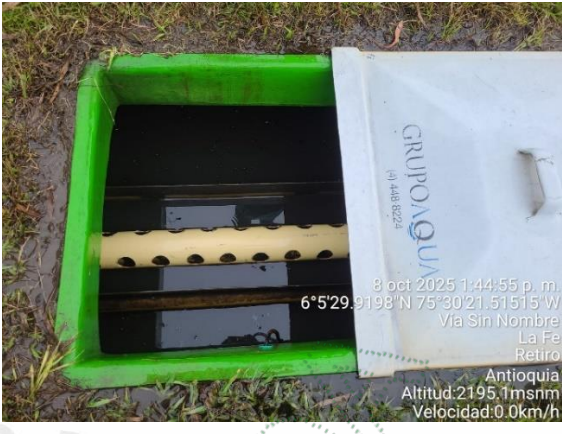
Fotografía 4. Planta OXI-AQUA. Cámara sedimentación
