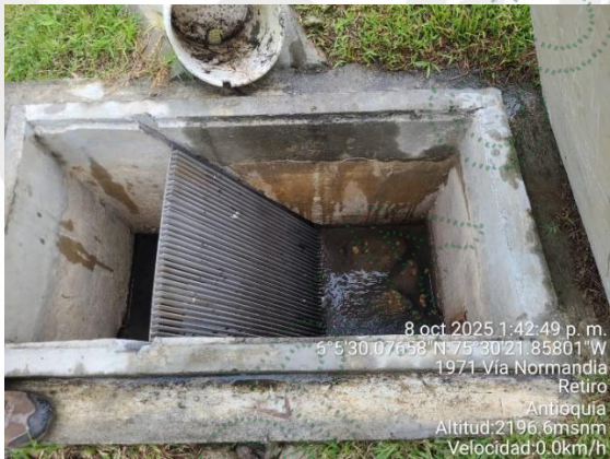
Fotografía 1. Canal de entrada y cribado
