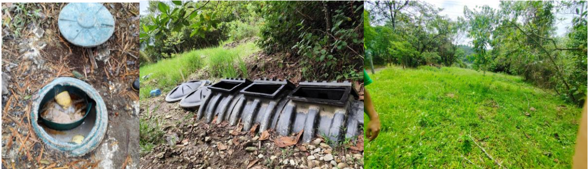
Foto 1,2,3: Trampa de grasas restaurantes. STAR. Campo de infiltración
