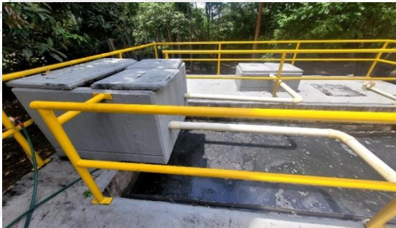
Fotografía 6. Reactor UASB existente, sin operar. Se proyecta la construcción de un nuevo UASB
