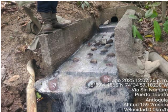
Fotografía 9. Estructura de descarga
