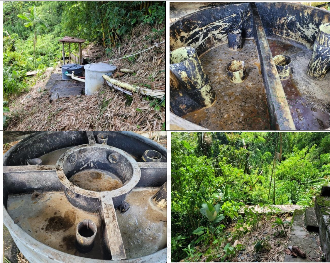
Imagen 5, 6, 7 y 8. Estado actual del sistema de tratamiento de aguas residuales domésticas – Trampas de grasas, Tanque séptico y FAFA
