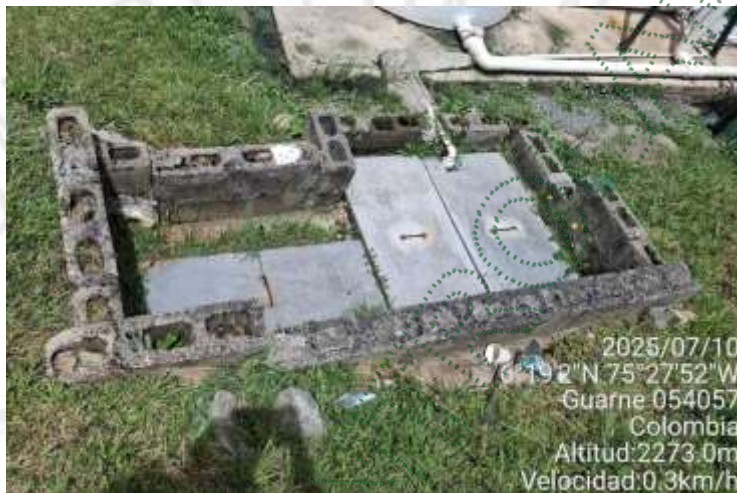
Imagen 3. Trampa de grasas y caja de registro
