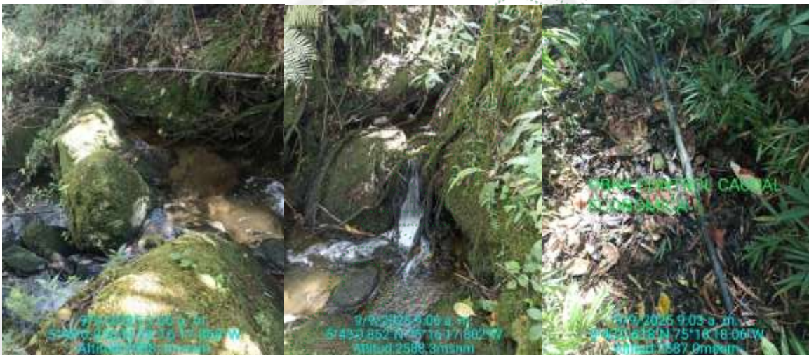
Captación fuente La Paloma y punto definido para obra captación y control de caudal recomendada
