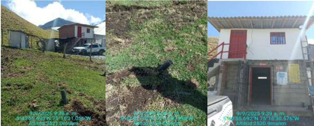
Vivienda y baño conectados a sumidero – vivienda arriba abajo bodega de agroquímicos
