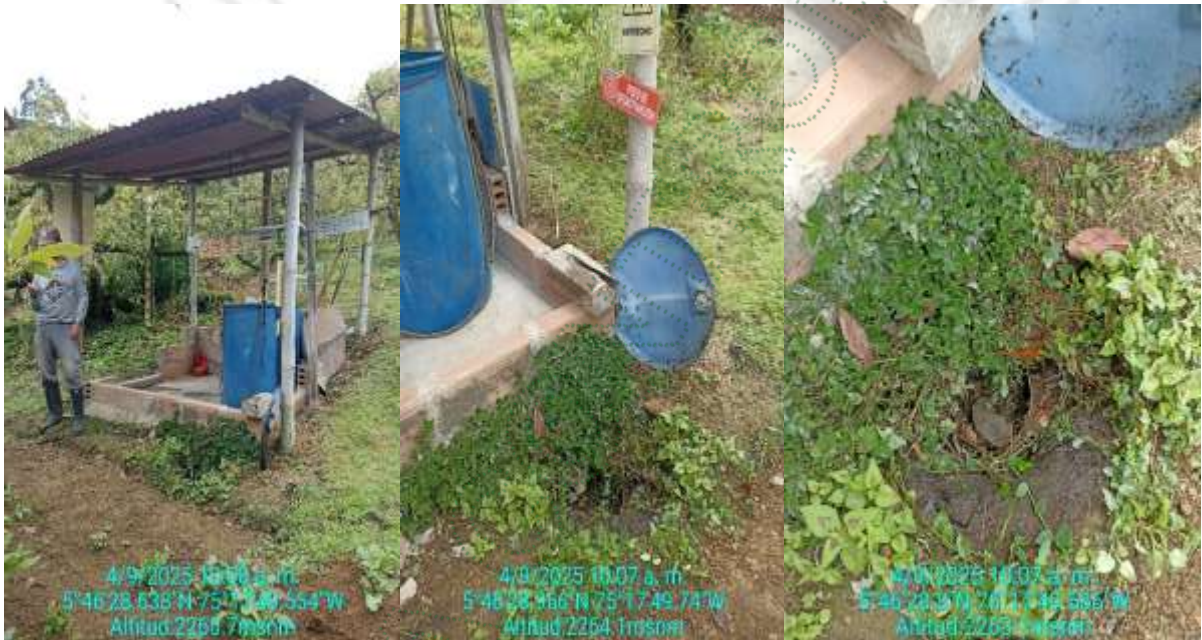
Punto de preparación de mezclas con pozo de desactivación
