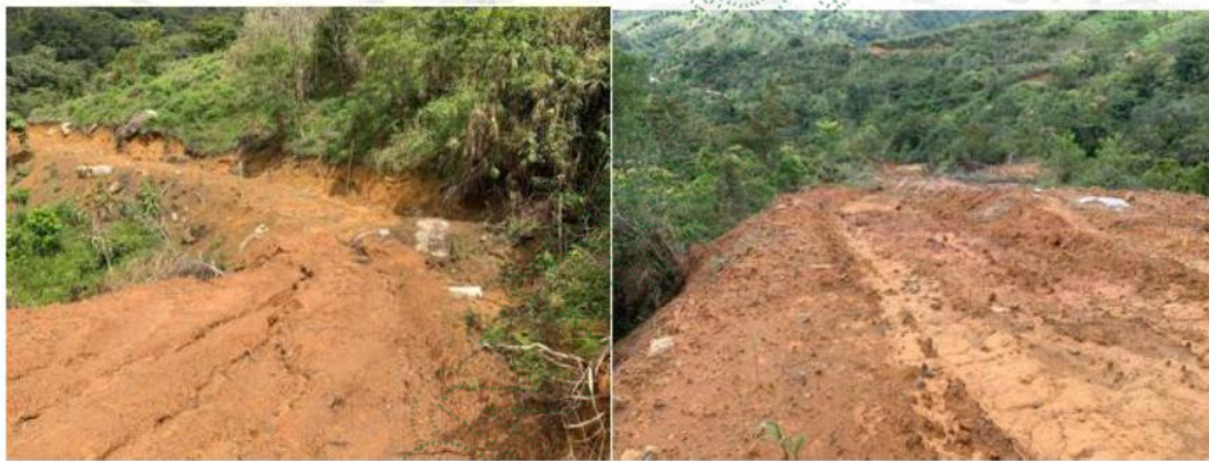
Figura 5. Apertura de vía
