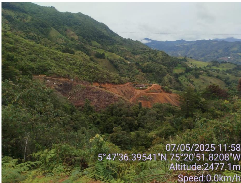
Apertura de vía.
