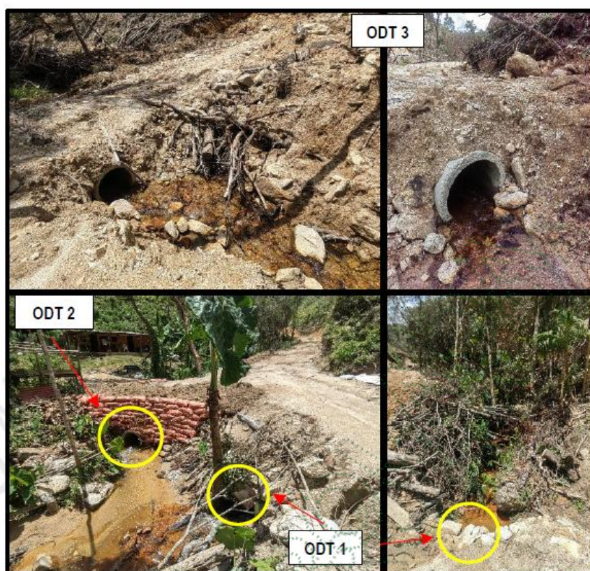
Imagen 6. Cornare. 2025. Obras de drenaje transversal instaladas para la continuidad del tramo 2 de la carretera.
