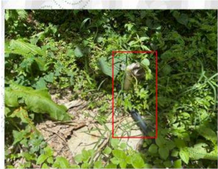
Imagen 4 Pozo Séptico Mampostería.
