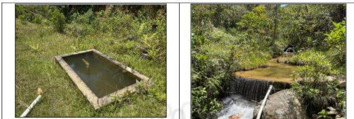
Imagen 2. Punto de Captación.
